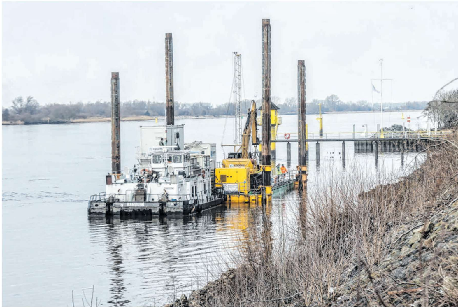
Das Ufer am Bernhardtring: Kampfmittelräumer suchen im Wasser nach Blindgängern, damit am Hang ein neuer Flutschutz gebaut werden kann.
