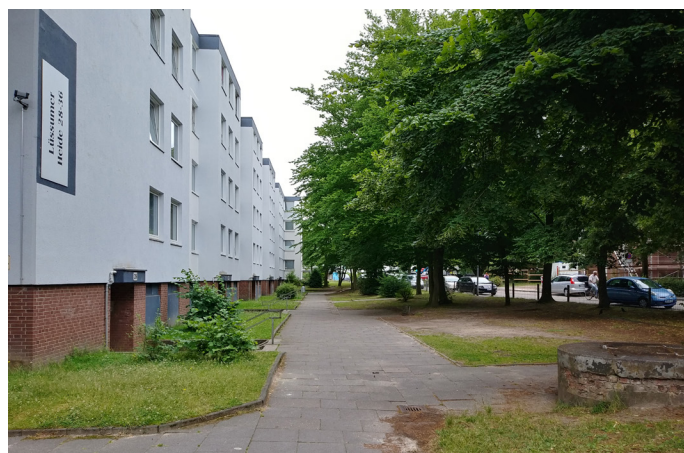
Abb. 13: Tiefliegender Eingangsbereich mit Treppen (p+t)
