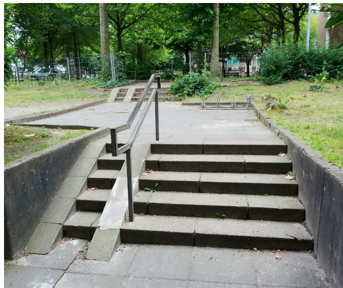
Abb. 11: Treppe im Eingangsbereich Gebäude 48 (p+t)
