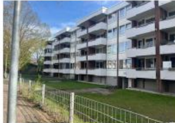
Abb. Gebäudebestand in 2025
