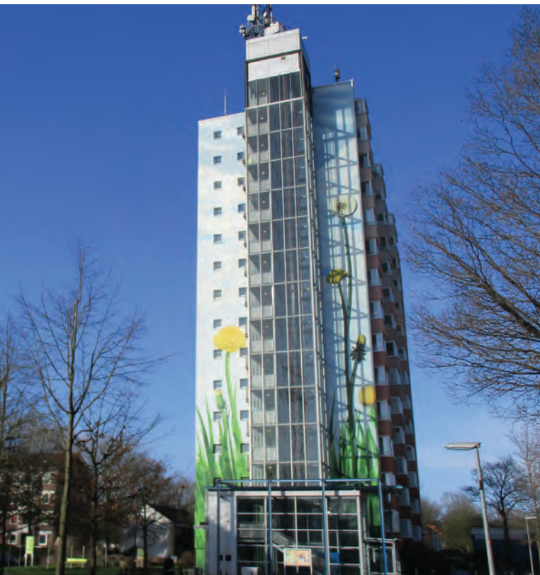
Abb. 10: Einziges noch verbliebenes Punkthochhaus im Lüssumer Ring 90
